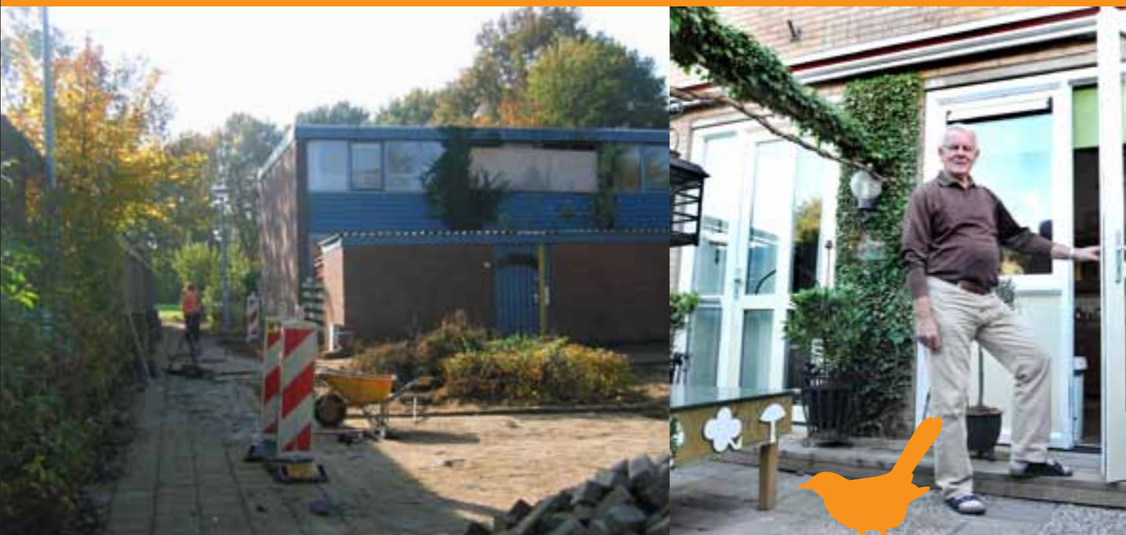
Momenteel worden in Het Bosveld de kabels en leidingen verlegd. Onder andere om ruimte te maken voor de bouwwerkzaamheden.
