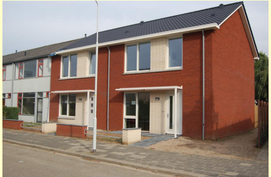
Modelwoning De Parkbuurt springt in het oog door totaal vernieuwde gevel en dak.
