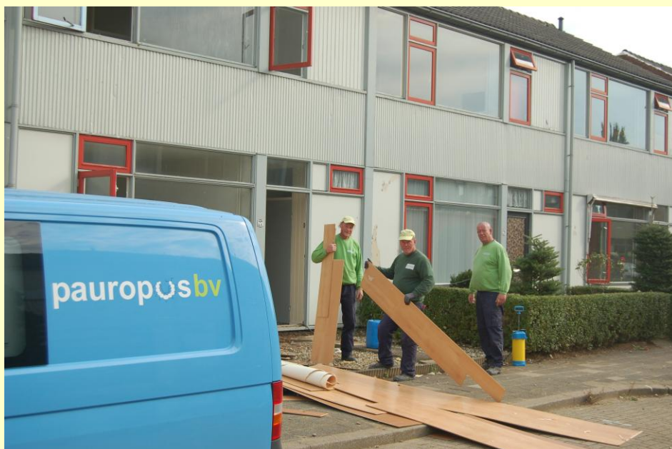
Pauropus maken verschillende woningen in De Parkbuurt klaar voor de renovatie werkzaamheden en strippen de woningen.
