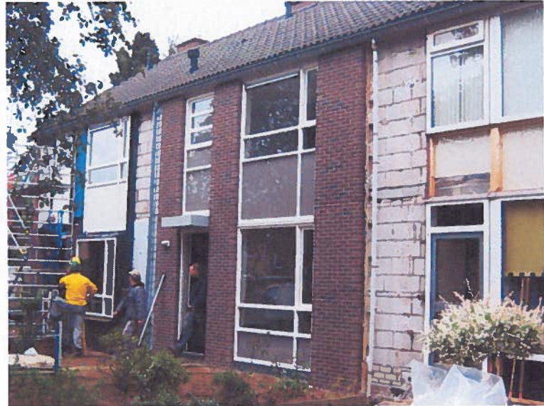
De renovatiwerkzaamheden zijn in volle gang.
